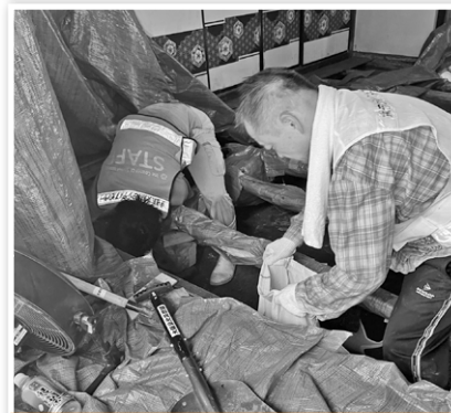
床下の泥を出すボランティア
